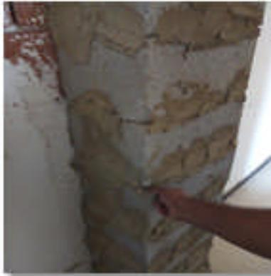
Mauvais jointolement des Shunts
