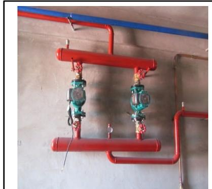
Absence de calorifuge de chauffage
