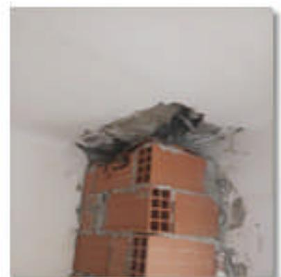
Mauvaise finition des réservations des Shunts aux niveaux des planchers
