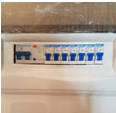
Manque la protection différentielle de 30 mA sur le circuit prise de courant
