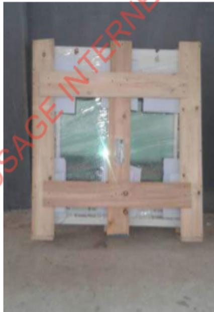
Figure 20. Stockage et protection des menuiseries Général Profile.
