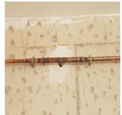
Collier de fixation sur soudure
