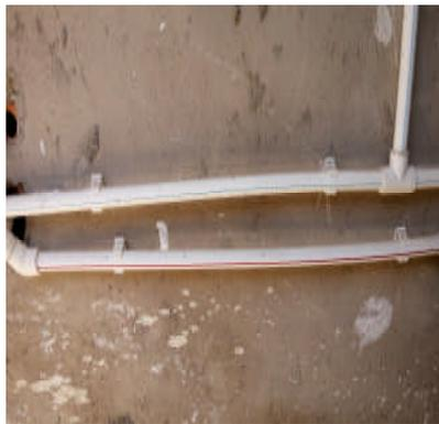
Tracé et supportage non conforme
